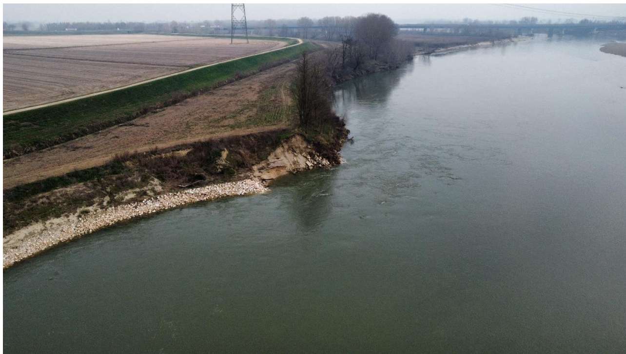
Figura 3 difesa spondale erosa (ripresa da UAS gennaio 2024).
