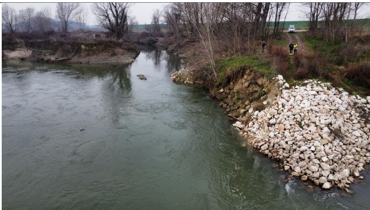
Figura 6 Stato di fatto – aree oggetto di erosione attiva che ha lesionato le opere di difesa presenti
